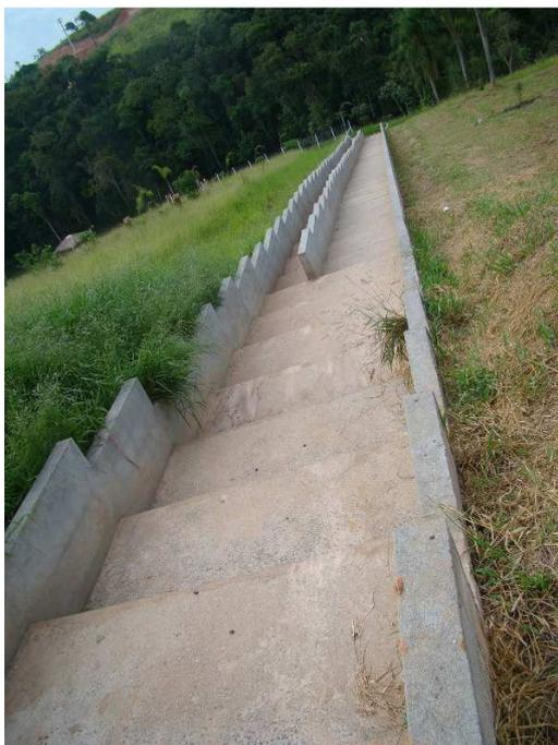
Figura 1 – Descida de água em degraus
