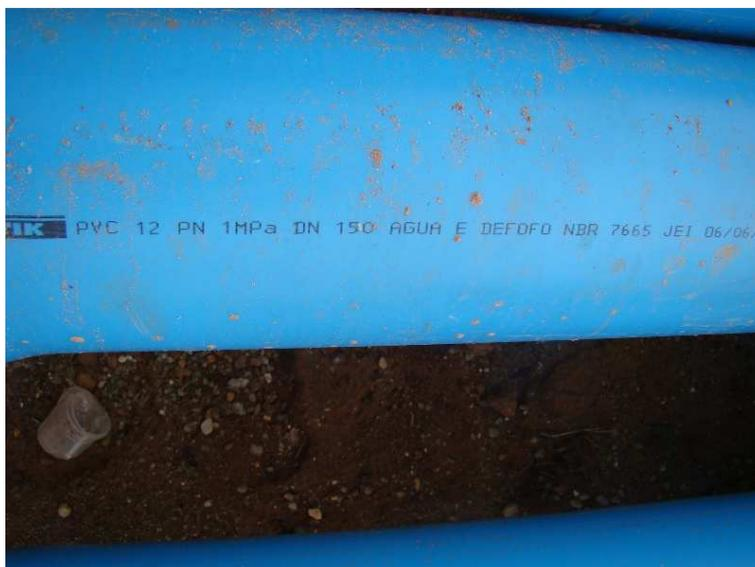
Figura 2 – Tubo DN 150mm DEFOFO utilizado na obra
