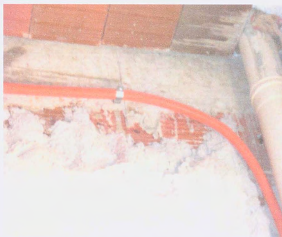
Figura 7 - Utilização de tubulações flexíveis para instalação elétrica
