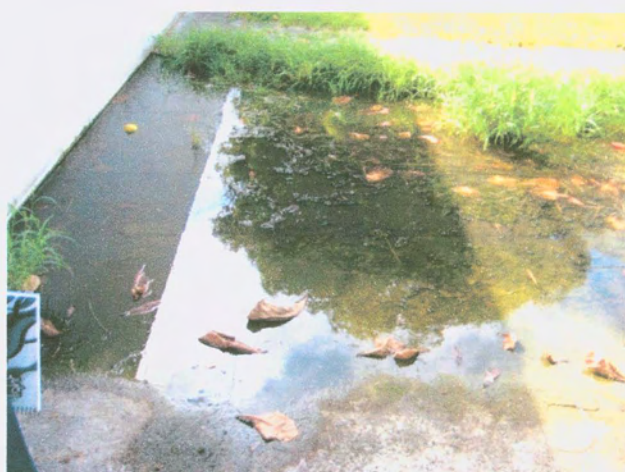
Figura 26 - Início da formação da piscina de esgoto
