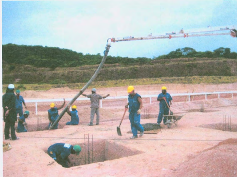
Figura 21 - Concretagem das sapatas (II)
