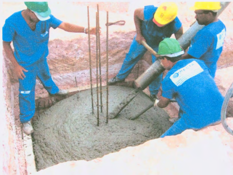
Figura 20 - Concretagem das sapatas (I)
