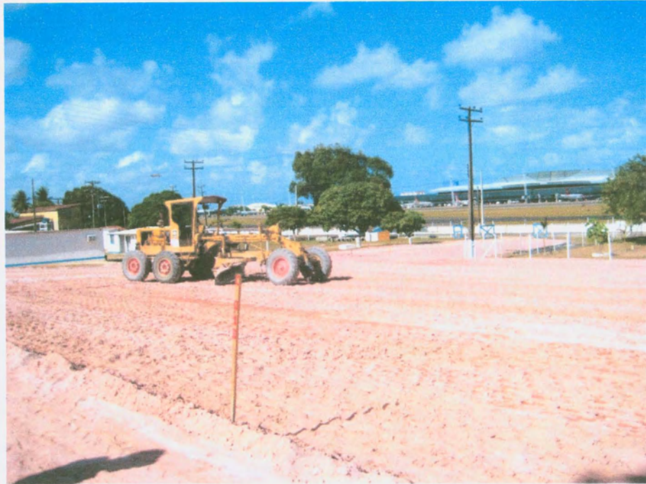
Figura 19 - Compactação do solo
