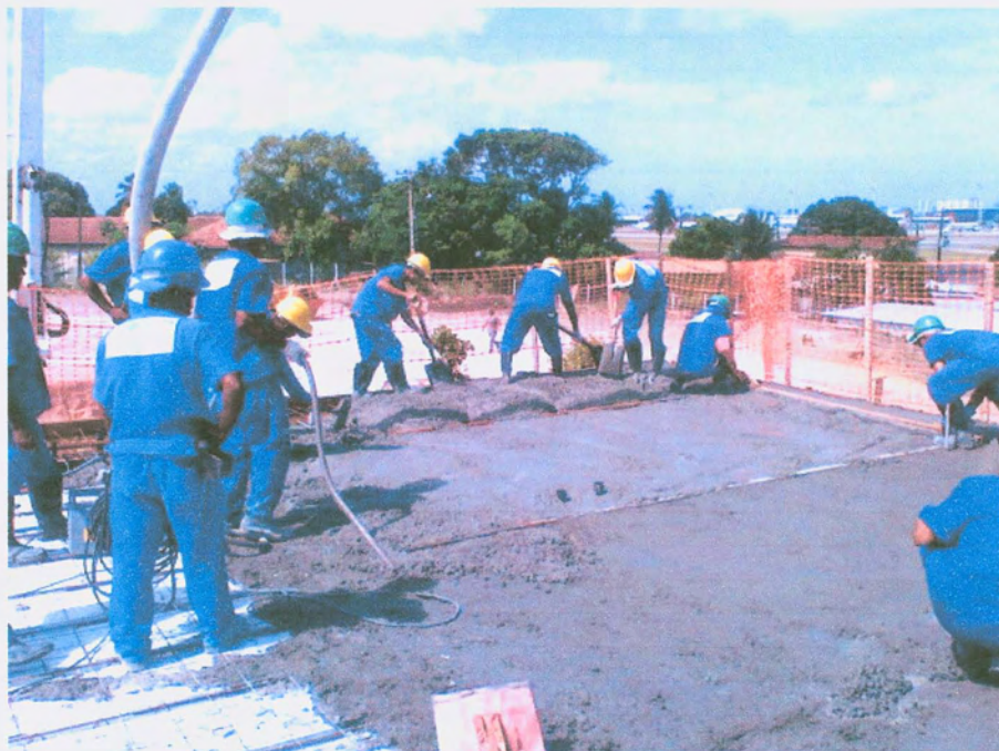
Figura 22 - Concretagem da laje
