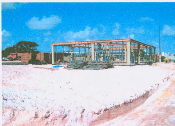
Figura 16 - Pilares do prédio de reação
