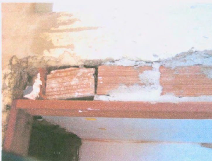
Figura 9 - Tijolos danificados
