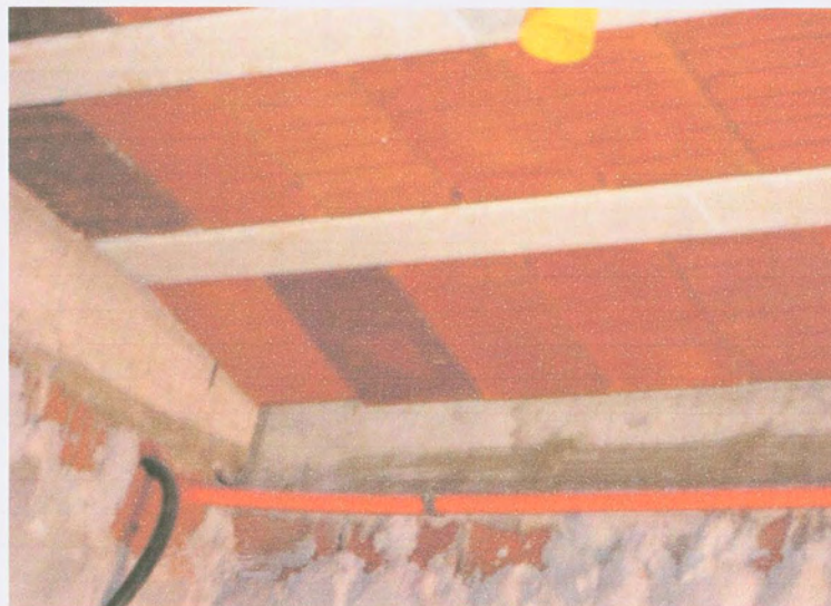
Figura 11 - Laje desalinha
