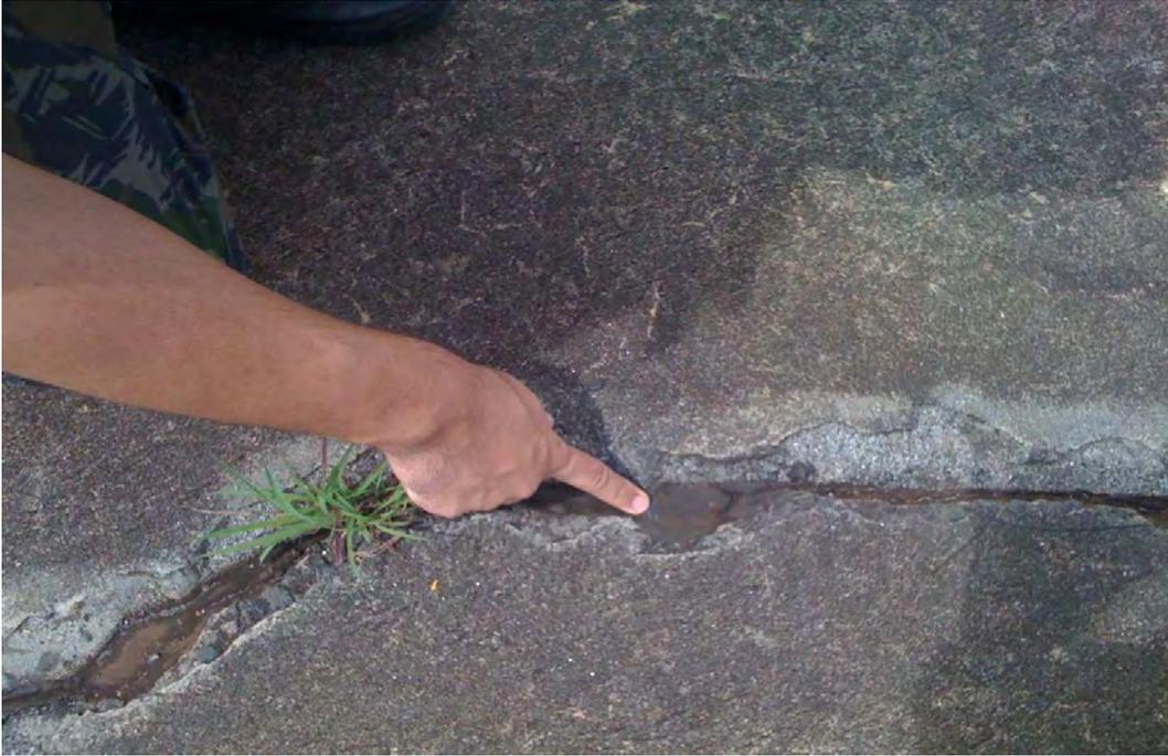
**Figura 1 - Rachaduras nas Áreas de Espera**
