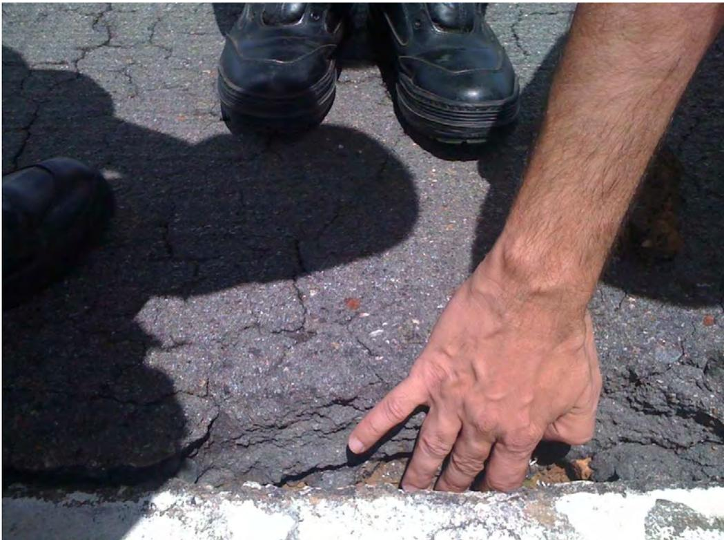
**Figura 2 - Rachadura Larga na Cabeceira da Pista**
