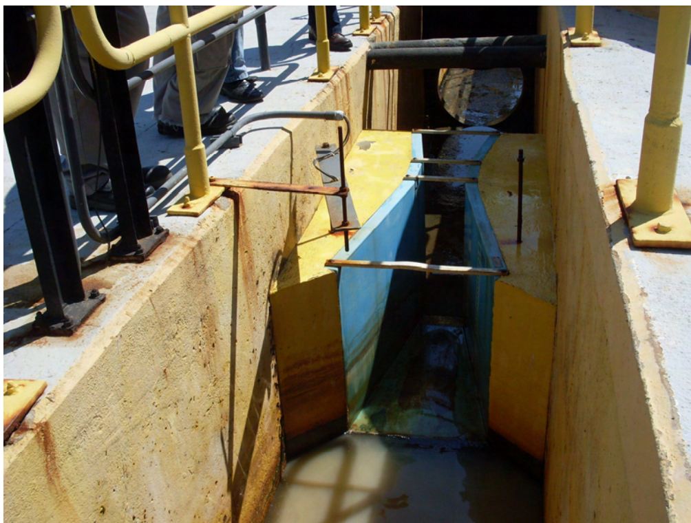
Figura 18- Calha Parshall
