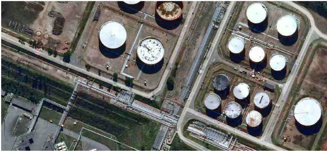
Figura 2- Terminal Transpetro - Guarulhos
