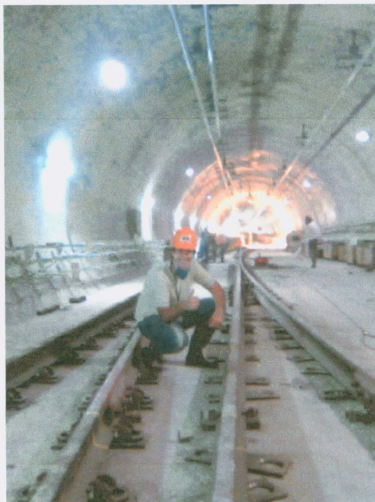
Figura 2 – Visita à Estação Morumbi da Linha 4 do Metrô de São Paulo
