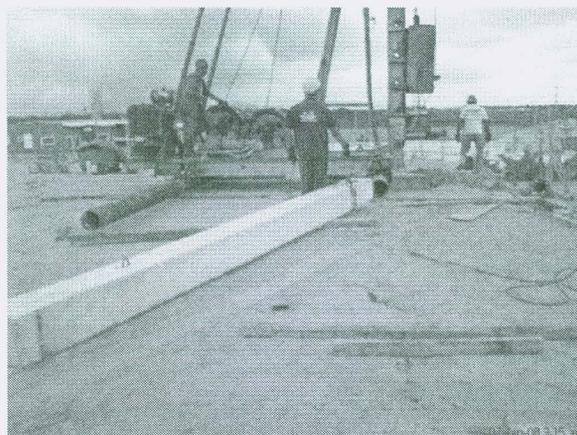
Figura 10: Bate-estaca levantando estaca para cravação.
