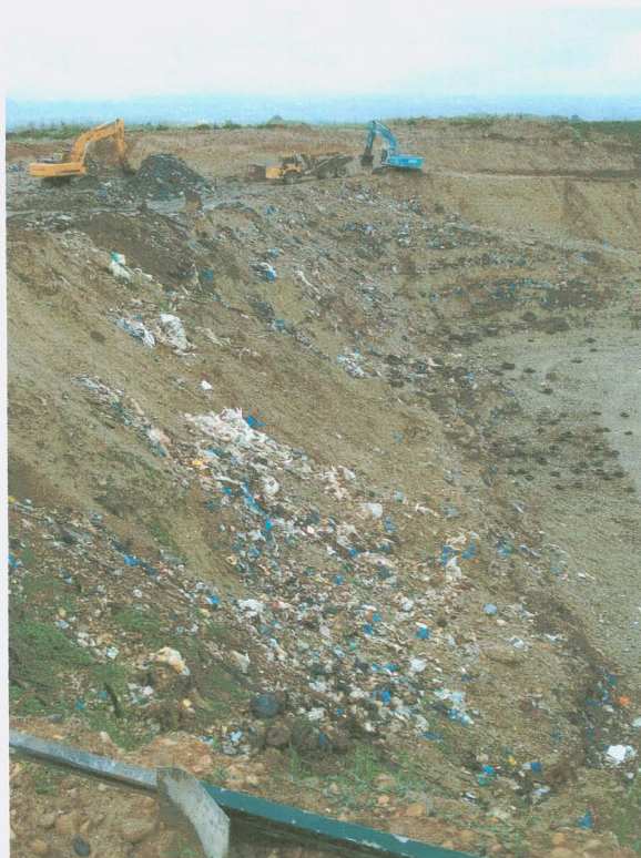
Figura 6 - Despejo de rejeitos no aterro.
