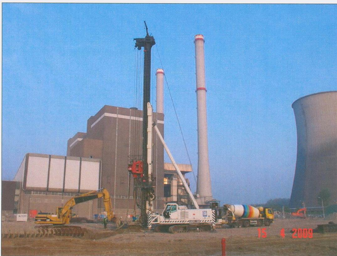
Figura 5 – Execução de estacas do tipo hélice contínua
