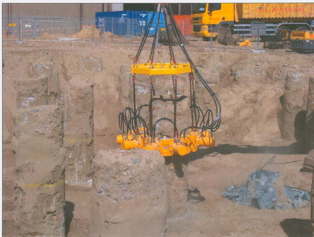
**Figura 7 – Corte de estacas**
