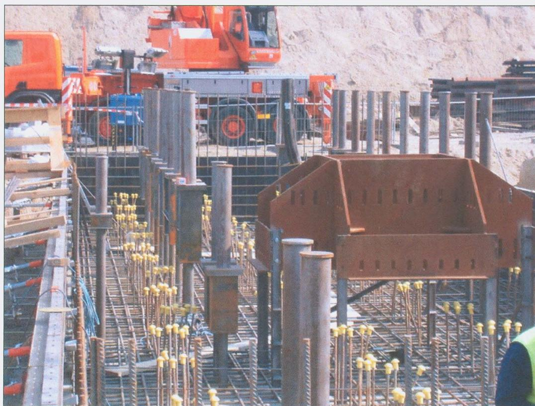
**Figura 9 – Armadura e inserções no prédio de GT**
