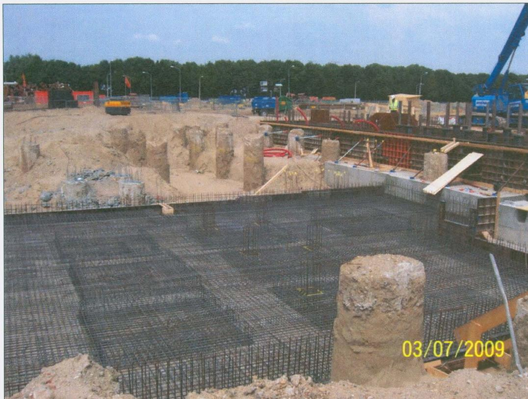
**Figura 8 – Armadura no módulo elétrico**
