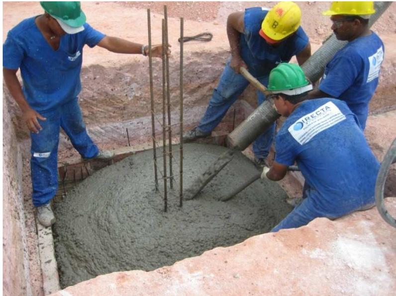
Figura 20 - Concretagem das sapatas (I)
