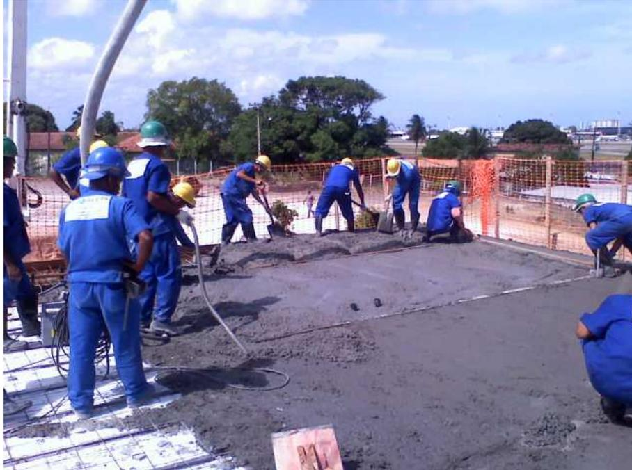
Figura 22 - Concretagem da laje
