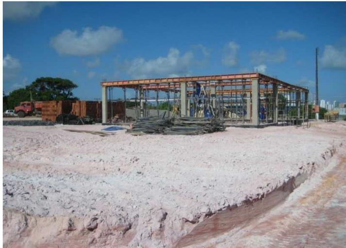
Figura 16 - Pilares do prédio de reação
