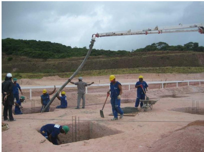
Figura 21 - Concretagem das sapatas (II)
