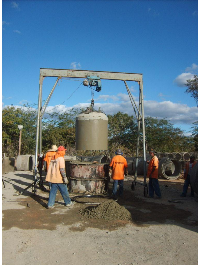
Figura 4. Fábrica de tubos em concreto armado
