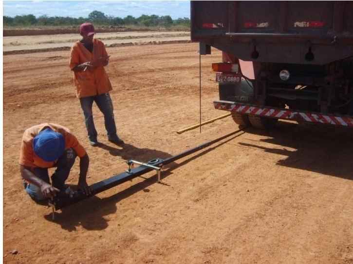
Figura 10. Deflectometria com Viga Benckelman
