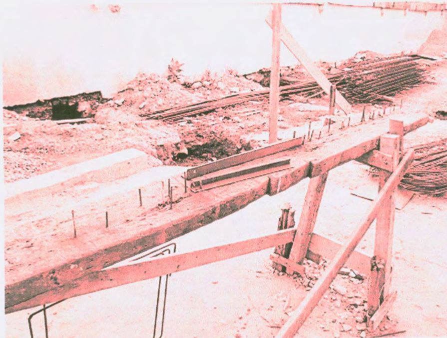
Fig 07 – Apetrecho utilizado para dobrar barras de aço.
