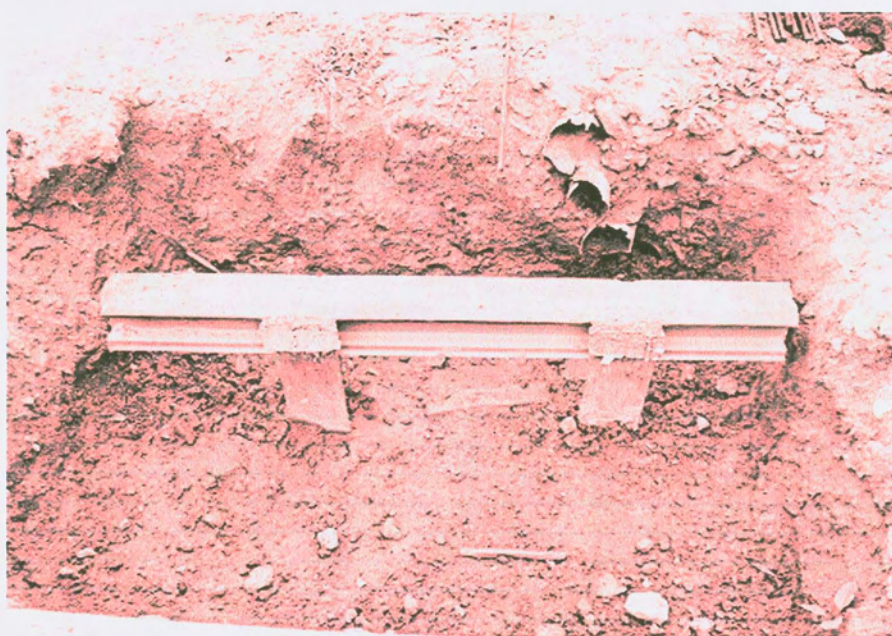
Fig 06 – Fotografia de uma estaca já cravada no terreno.
