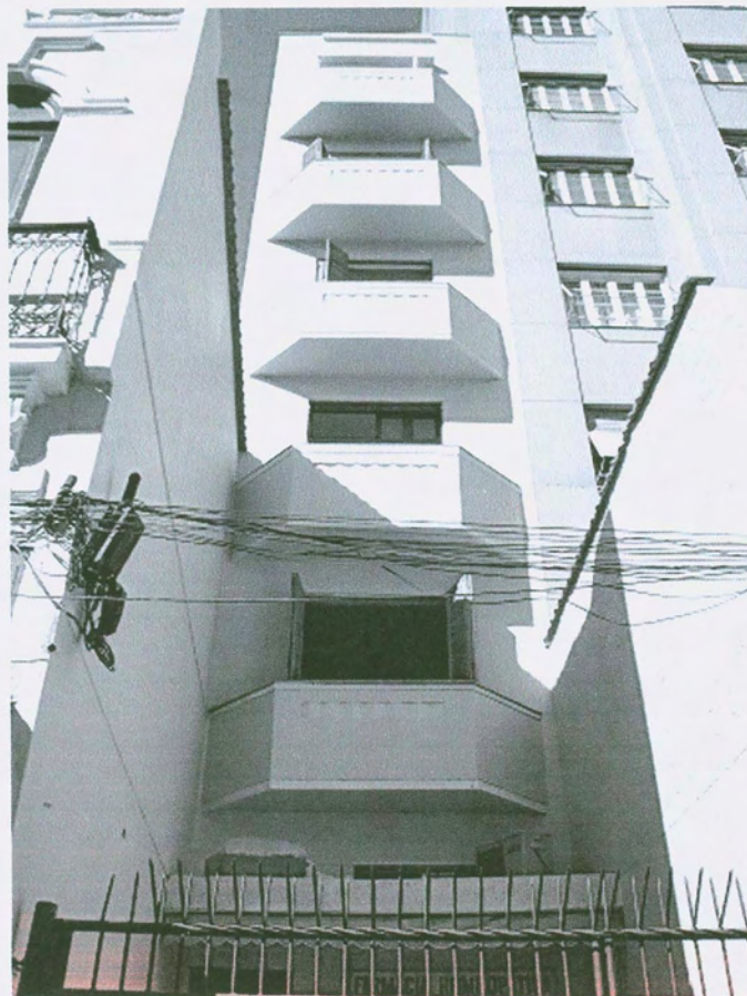
Fig 03 – Foto da fachada do edifício após a reforma.
