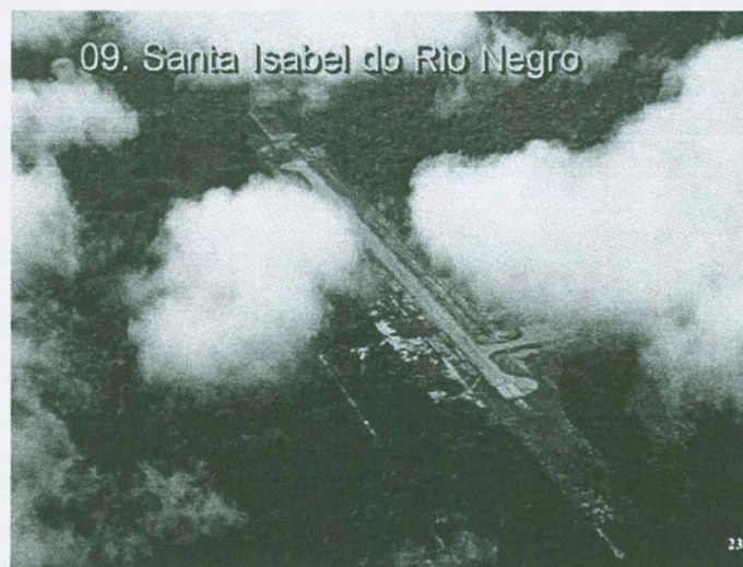
Figura B.17 – Vista Aérea do Aeroporto de Santa Isabel do Rio Negro.
