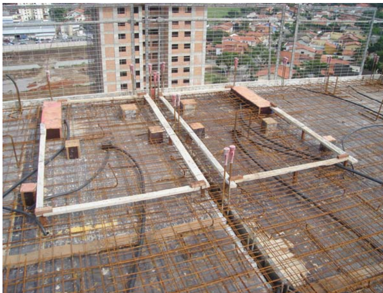
Figura 26: Delimitação da laje das áreas úmidas.
