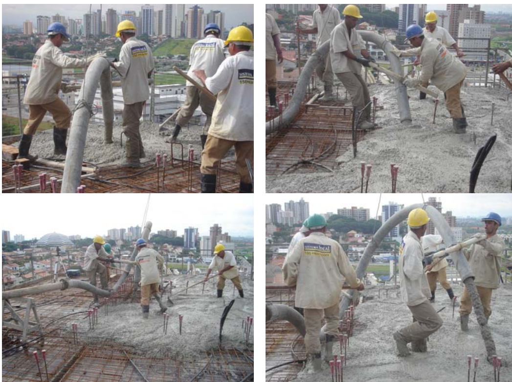
Figura 32: Detalhes do início da concretagem.
