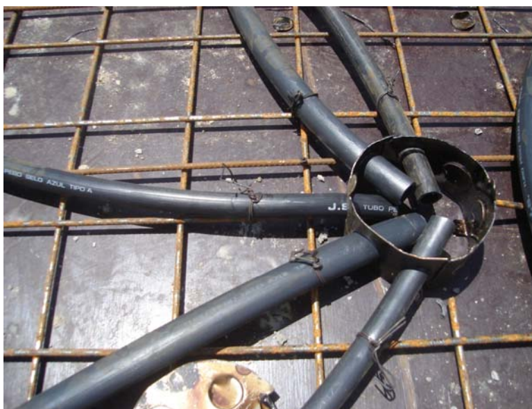
Figura 17: Detalhe da caixa de tubulação elétrica.
