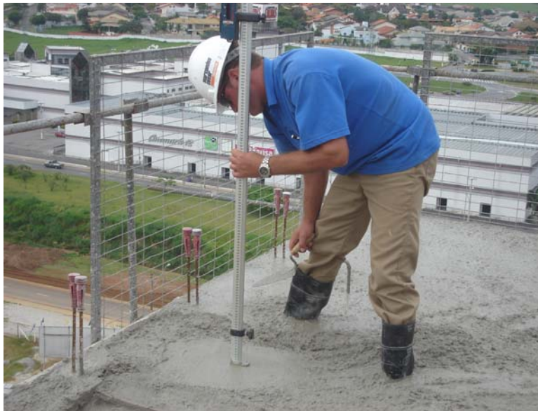
Figura 34: Controle da espessura das lajes.
