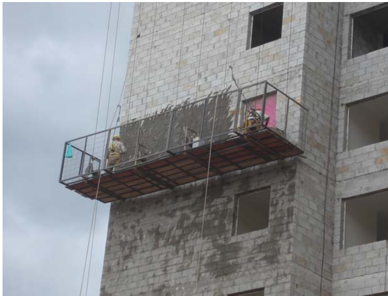
Figura 5: Chapisco executado na fachada do prédio.
