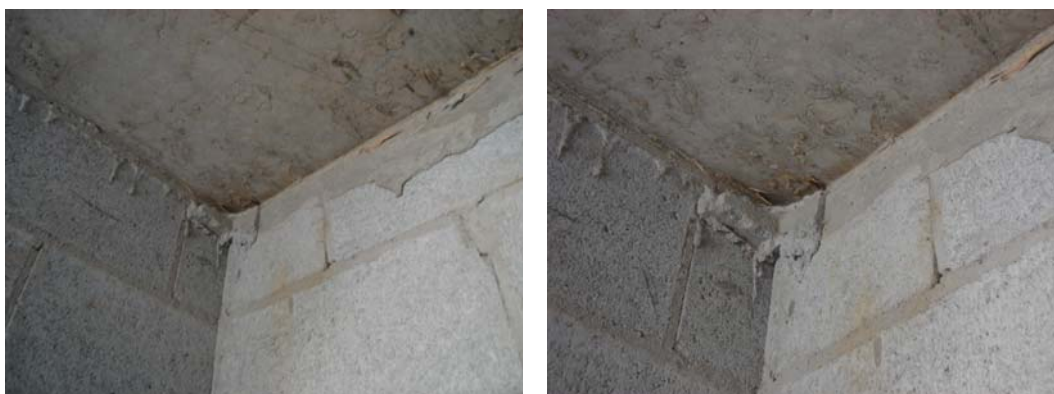
Figura 49: Detalhe dos locais onde será executada a “poda”.
