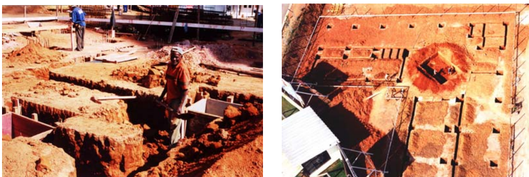
Figura 3: Escavação para os baldrames e estacas do edifício.
