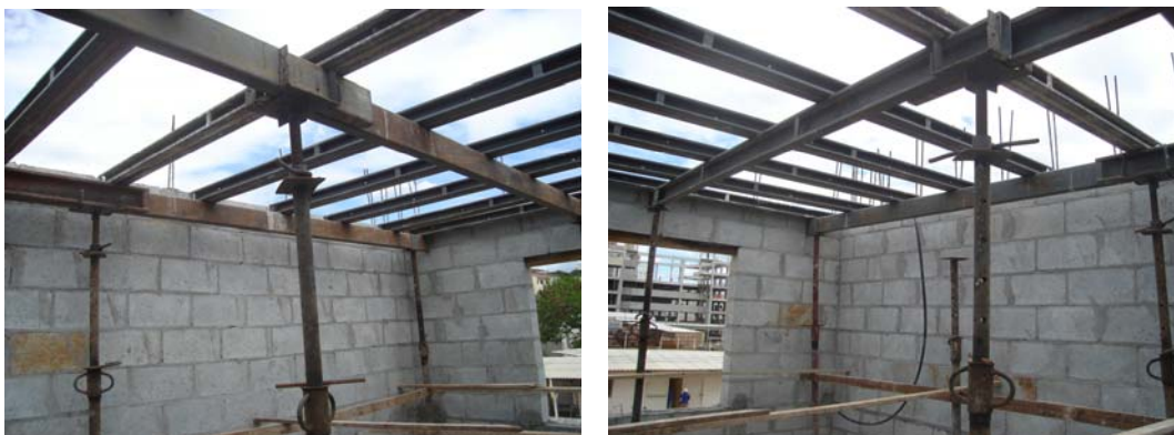
Figura 9: Barrotes e longarinas apoiados nas escoras.
