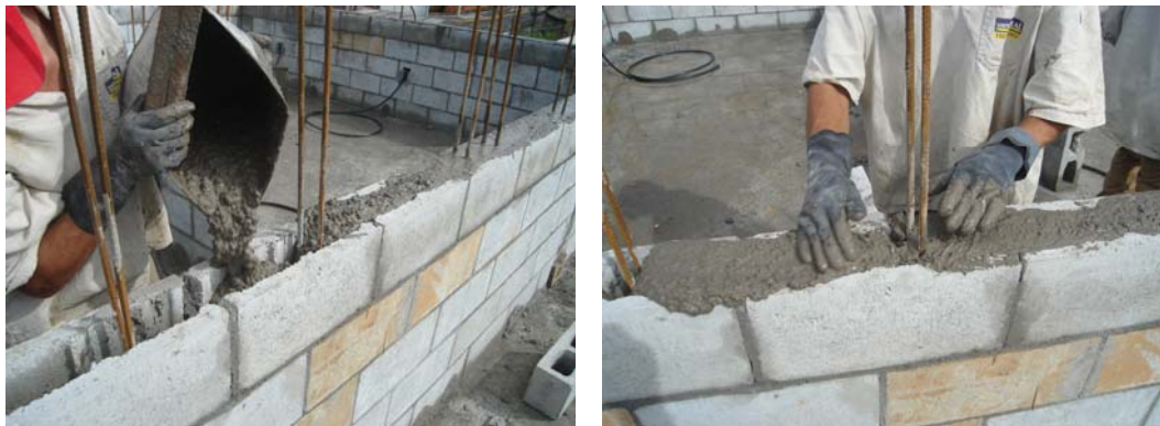
Figura 46: Espalha do graute.
