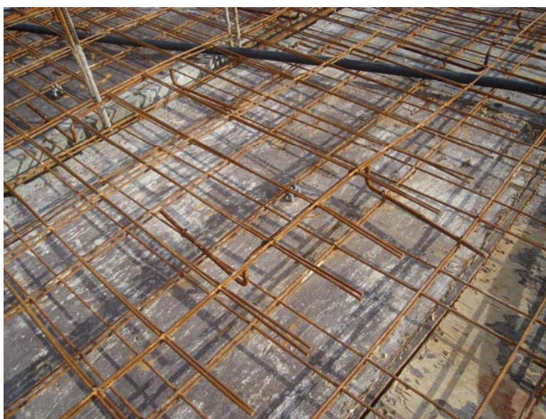
Figura 24: Utilização do “caranguejo” para sustentar a armadura negativa.
