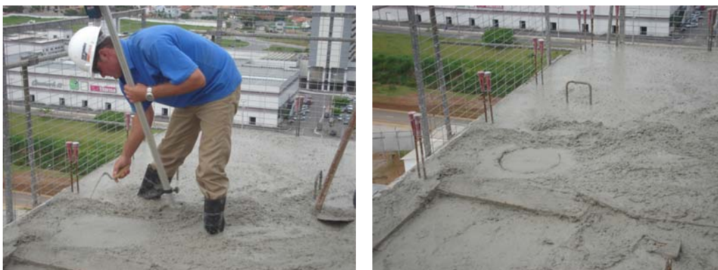
Figura 35: Detalhe da marcação indicativa de conformidade com o projeto.
