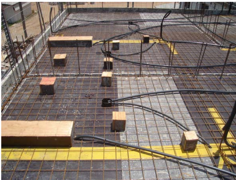
Figura 20: Detalhe das caixas de madeira sobre o assoalho.
