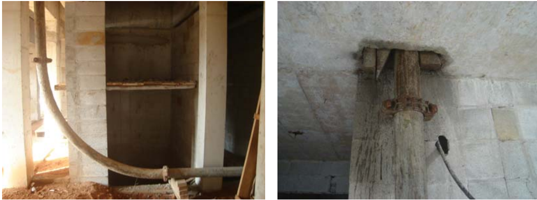
Figura 31: Detalhe da tubulação por onde passa o concreto.
