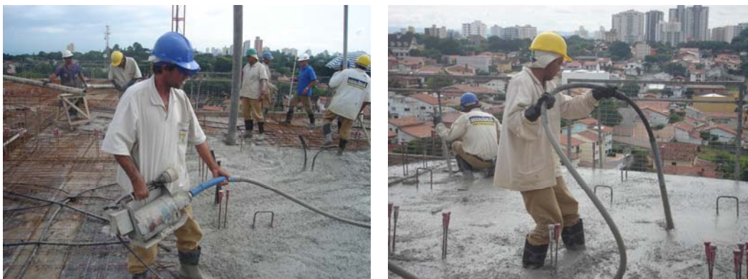
Figura 33: Detalhe do vibrador utilizado.
