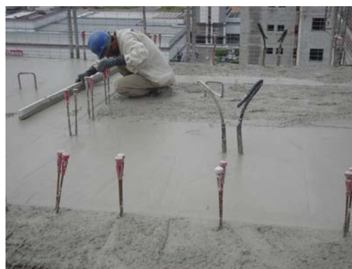
Figura 38: Detalhe da execução do nivelamento da laje.
