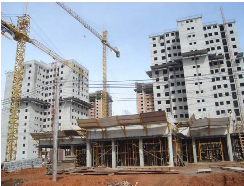
Figura 1: Edifícios em construção (dois deles executados até o 15º pavimento e o outro executado até o 1º).
