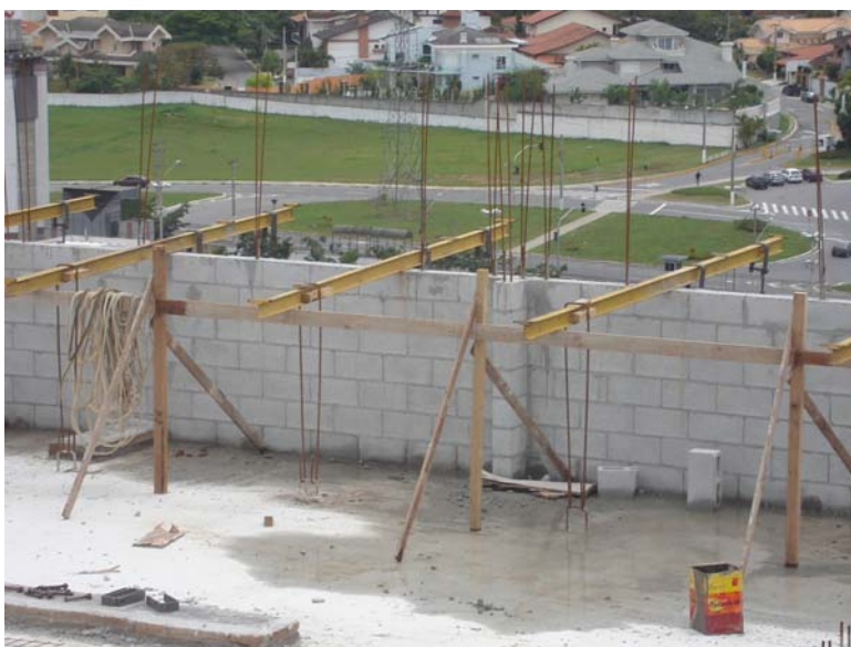
Figura 16: Montagem do sistema de apoio do “balancinho”.
