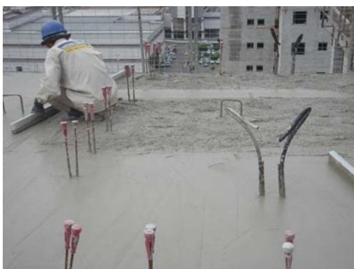
Figura 38: Detalhe da execução do nivelamento da laje.
