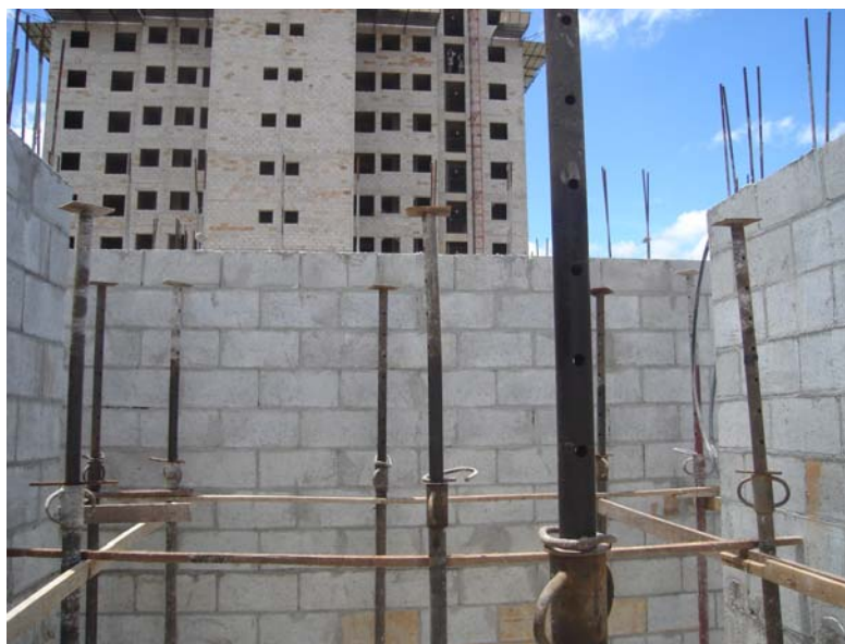
Figura 7: Escoras das formas do 1º pavimento e travamento lateral.
