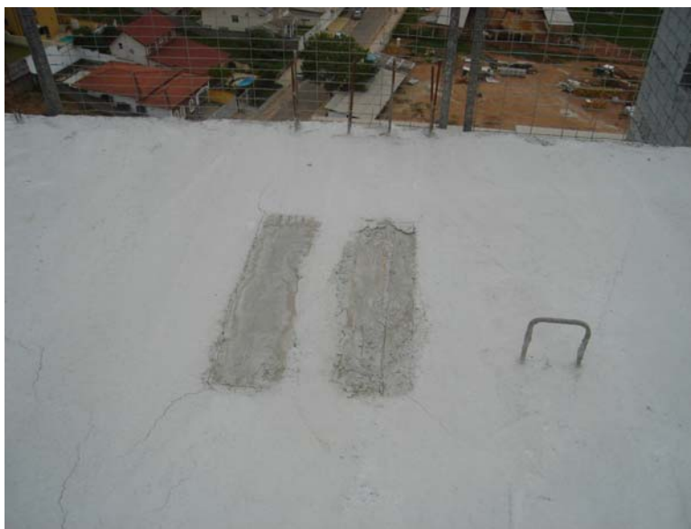
Figura 43: Detalhe de um local onde havia caixa de madeira no assoalho.
