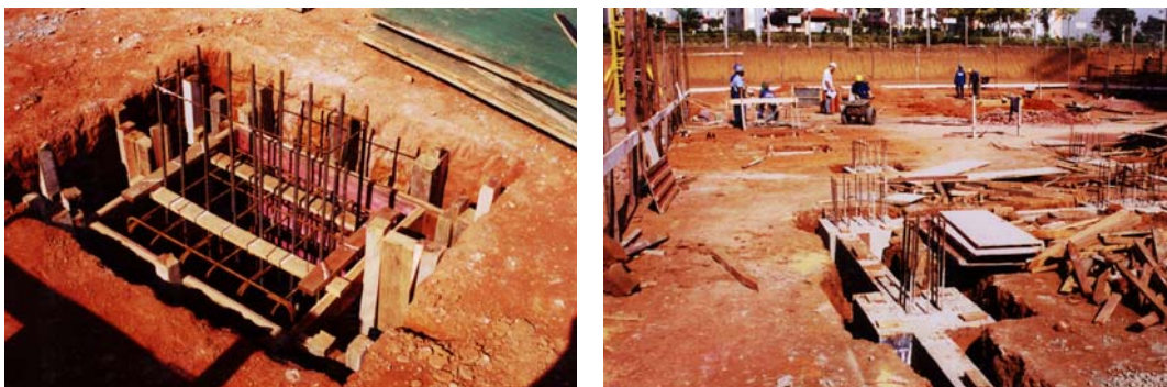
Figura 4: Armaduras das estacas (esq) e baldrames já concretados (dir).
