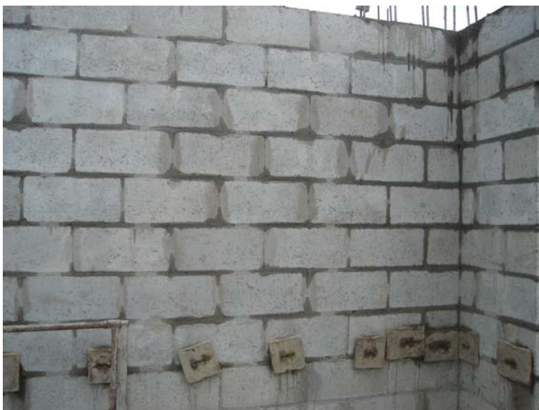
Figura 45: Detalhe das madeiras colocadas nos buracos feitos para limpeza.
