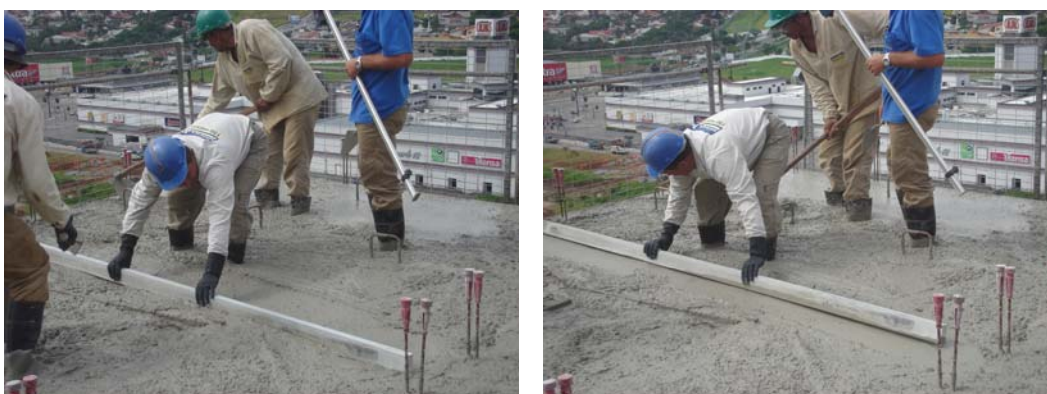
Figura 36: Operário nivelando dois pontos de conformidade com o projeto.
