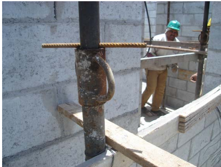
Figura 8: Detalhe do ajuste de altura das escoras metálicas.
