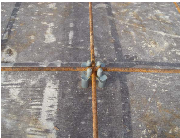
Figura 14: Detalhe da “pastilha”.
