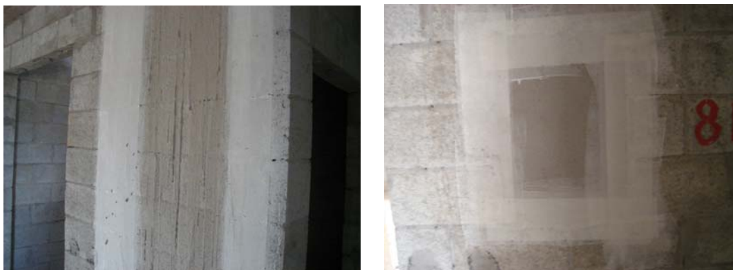
Figura 48: Detalhes da aplicação da tela vinitrinca.
