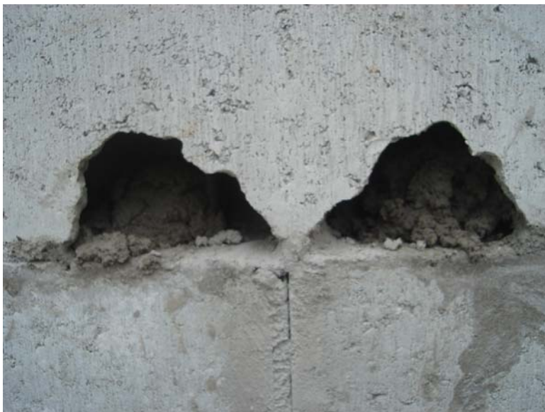
Figura 44: Detalhe de um buraco feito para limpar o bloco estrutural (presença de argamassa no interior).
