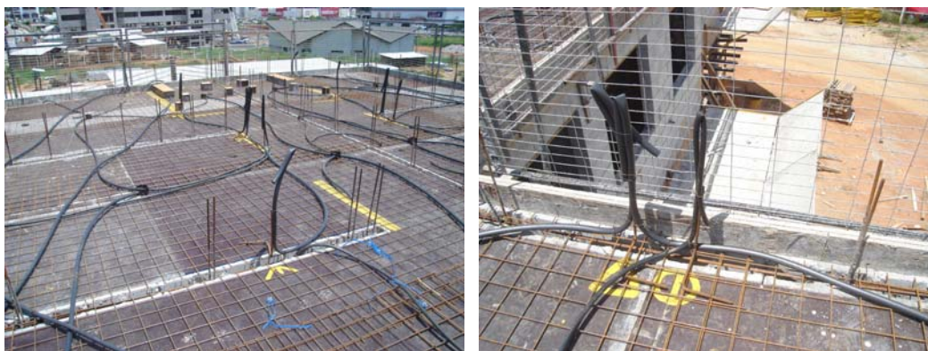
Figura 13: Detalhe das marcações no assoalho.
