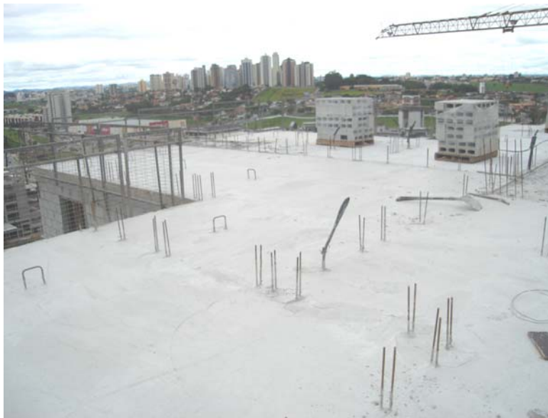
Figura 40: Laje já com concreto seco.
