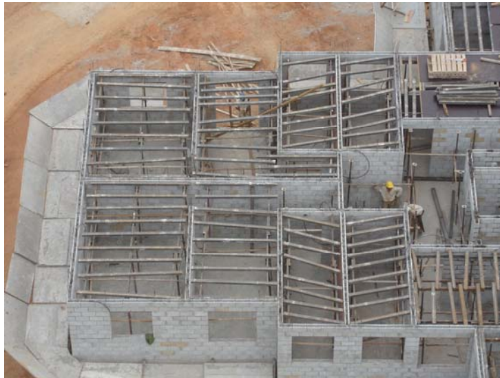
Figura 10: Detalhe de barrotes inclinados nos cômodos pequenos.
