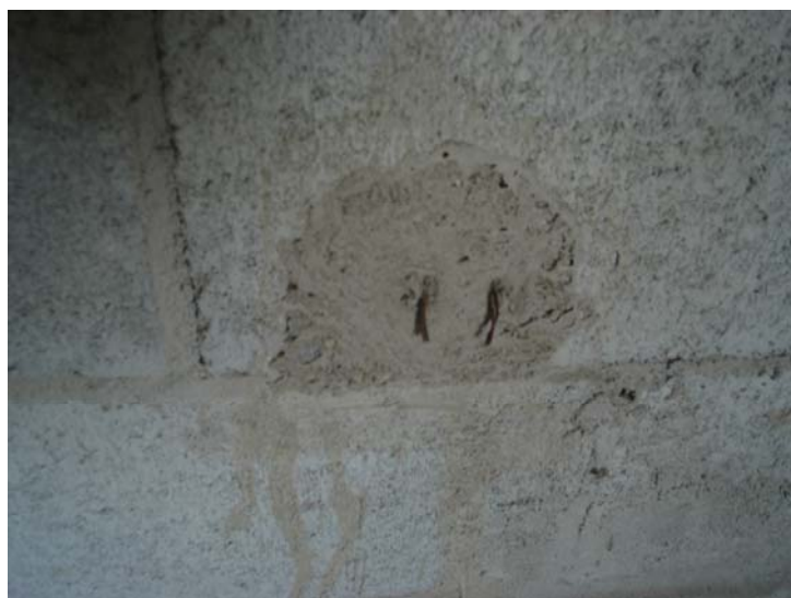
Figura 47: Detalhe do arame de amarração preso no graute.
