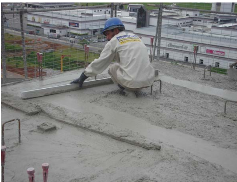
Figura 37: Operário realizando nivelamento entre duas regiões niveladas anteriormente.
