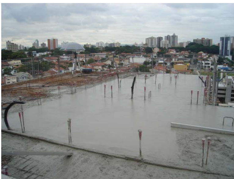
Figura 39: Detalhe de parte da laje nivelada.
