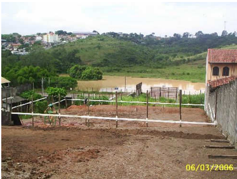
Figura 1: Canteiro de Obras ( Gabarito )
