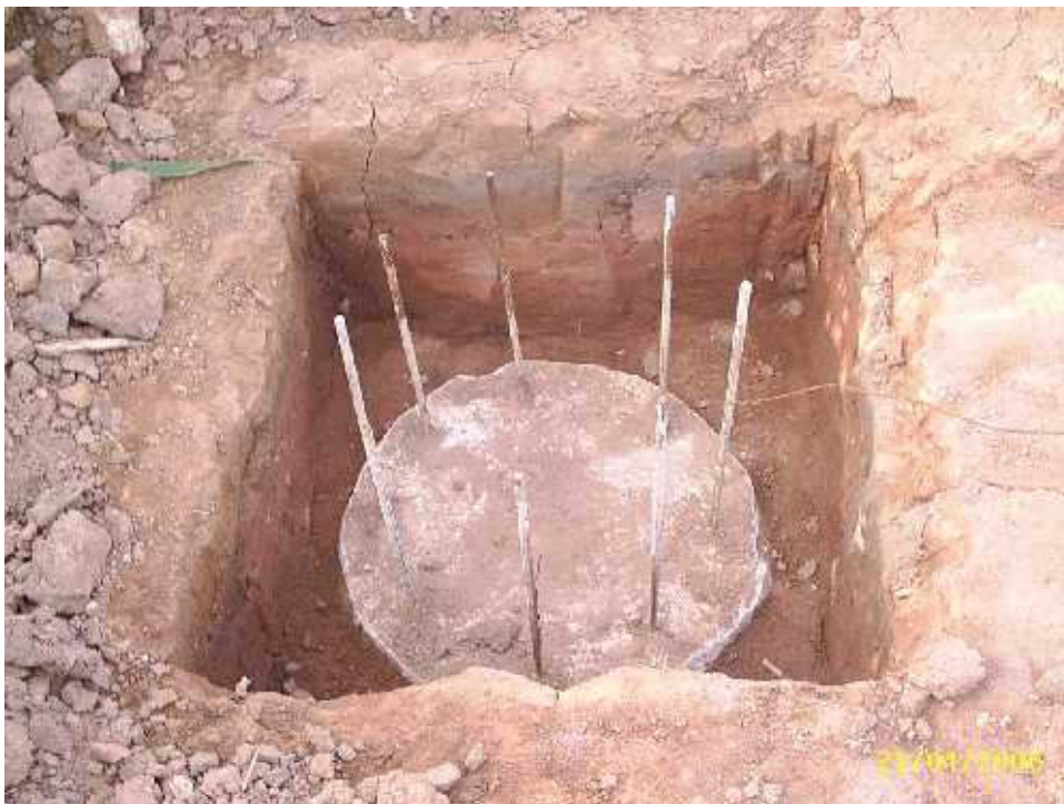
Figura 7: Detalhe do Tubulão e vala para concretagem dos blocos estruturais
