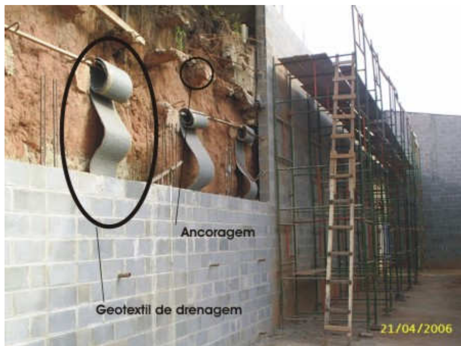
Figura 9: Muro de arrimo
