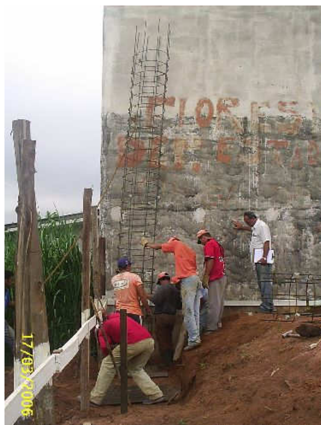
Figura 3: Colocação da armadura (fuste com 8 m , armadura com 6m)
