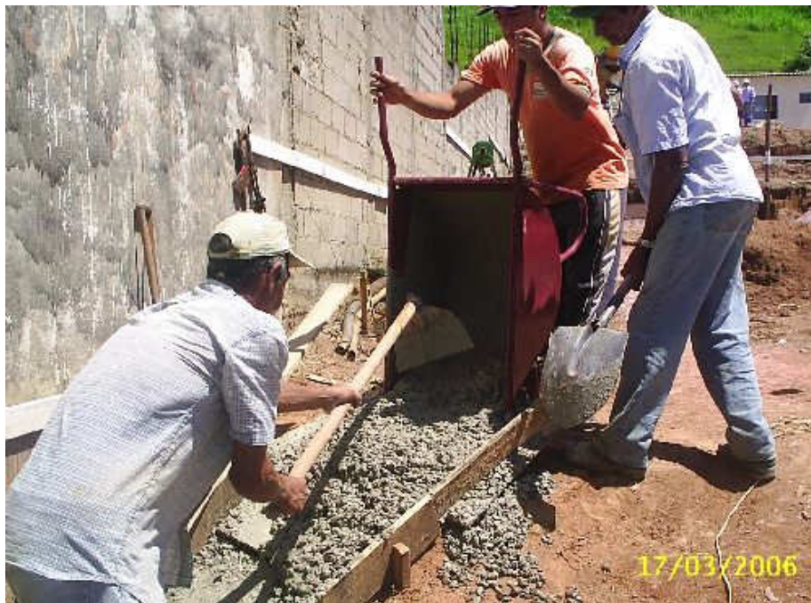
Figura 4: Concretagem dos Tubulões
