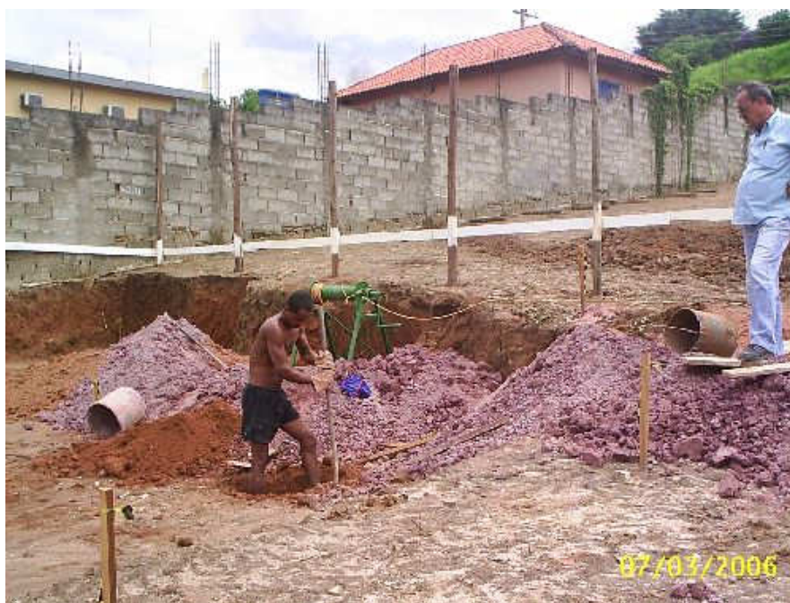
Figura 2: Escavação manual dos fustes (buraco)
