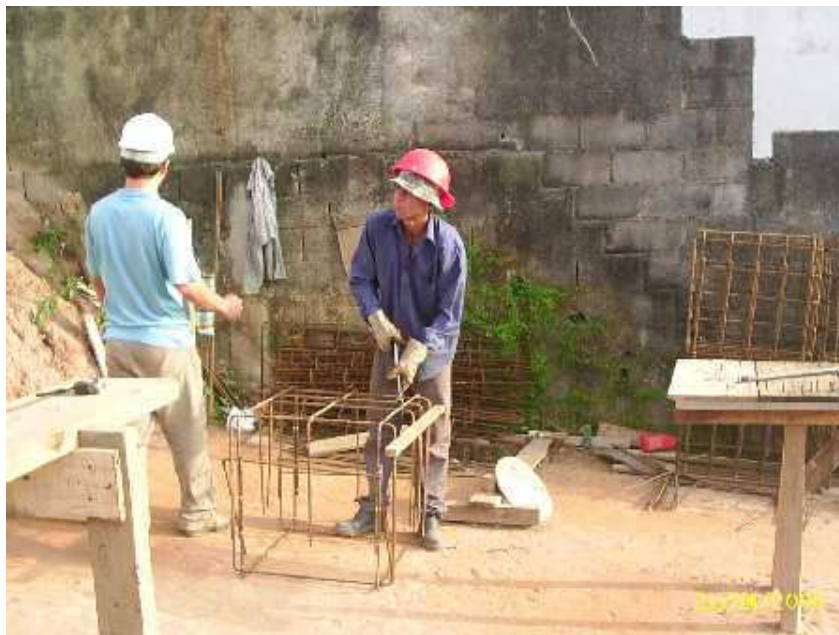
Figura 5: Dobragem da armadura dos blocos estruturais
