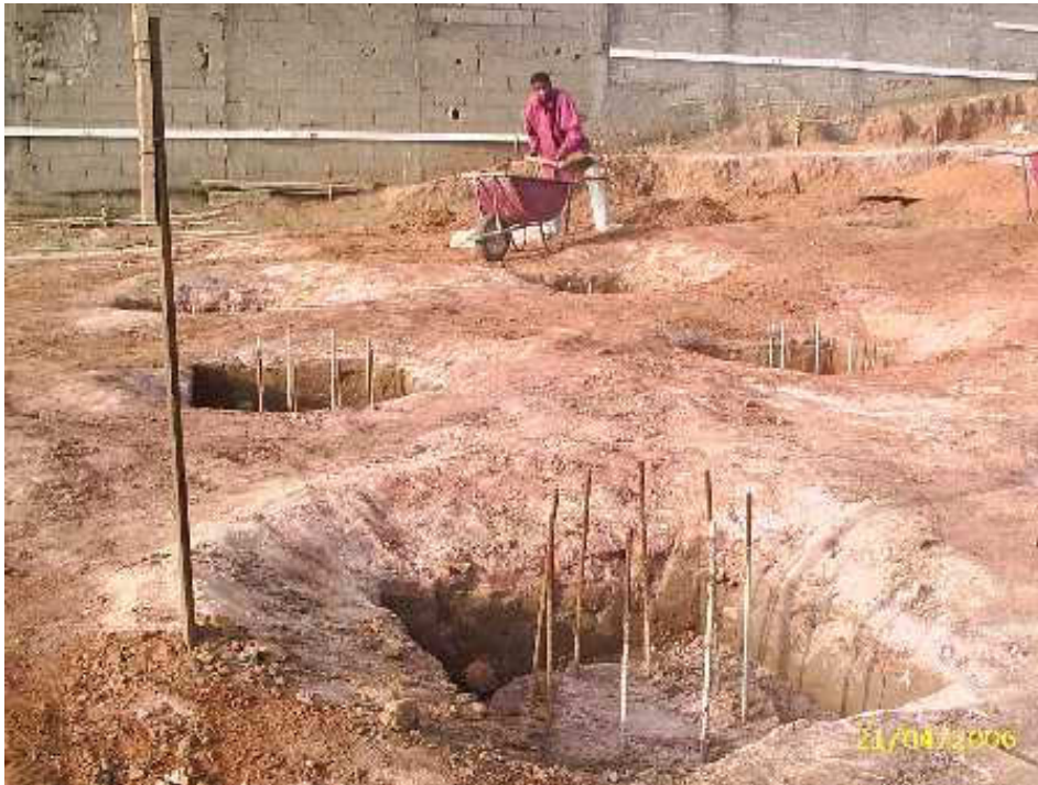
Figura 6: Tubulões concretados e armadura de espera
