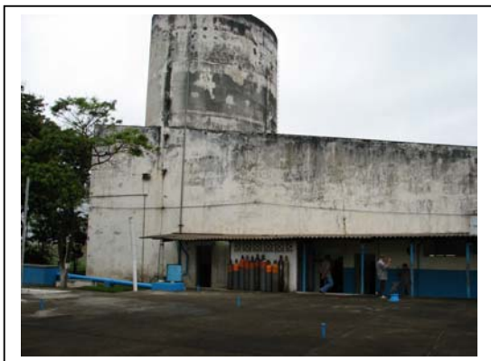
Fig. 01 - Vista Externa da ETA
