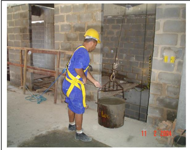
Figura 2 – Operário Utilizando Equipamentos de Segurança
