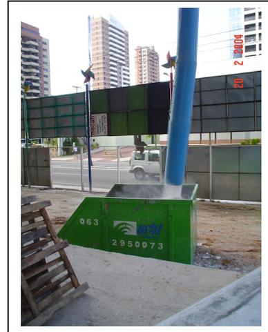
Figura 3 – Tubulação para Remoção de Entulho
