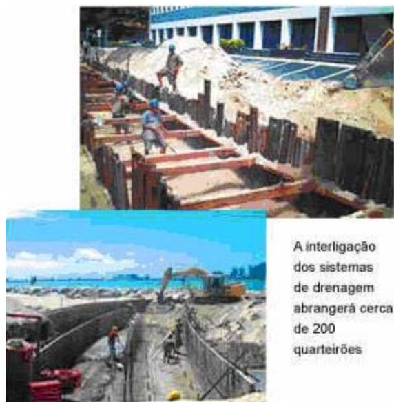
**Figura 4:** Etapas de escavação e concretagem.
