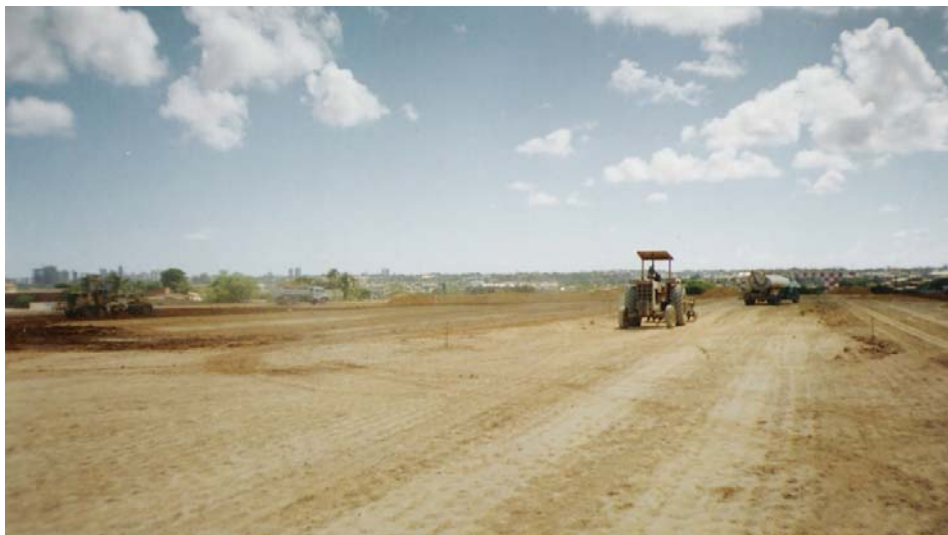
Figura 5: Ajuste da umidade do aterro com motoniveladora.
