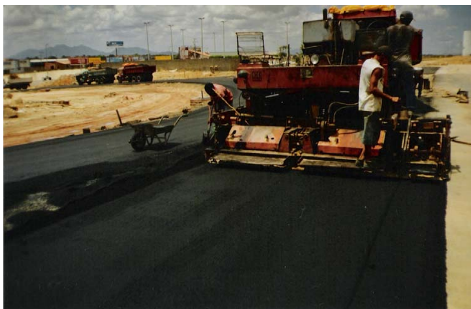
Figura 9: Equipamento de pavimentação.
