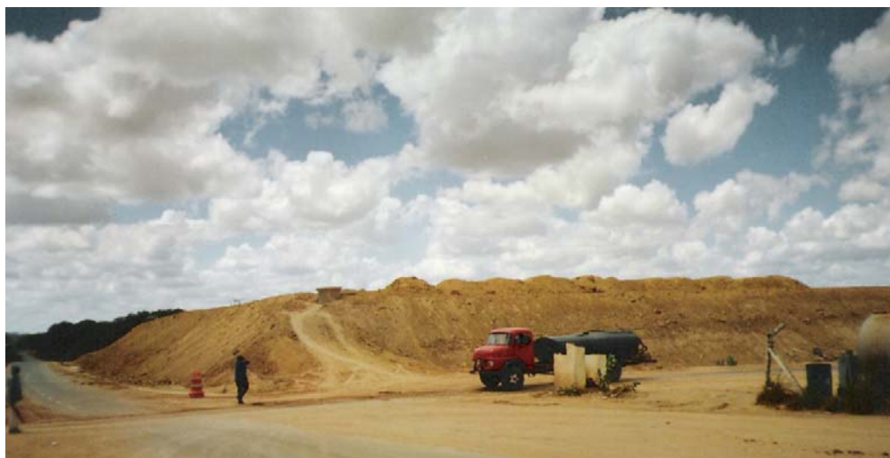
Figura 4: Aterro construído para ampliação da pista do aeroporto.
