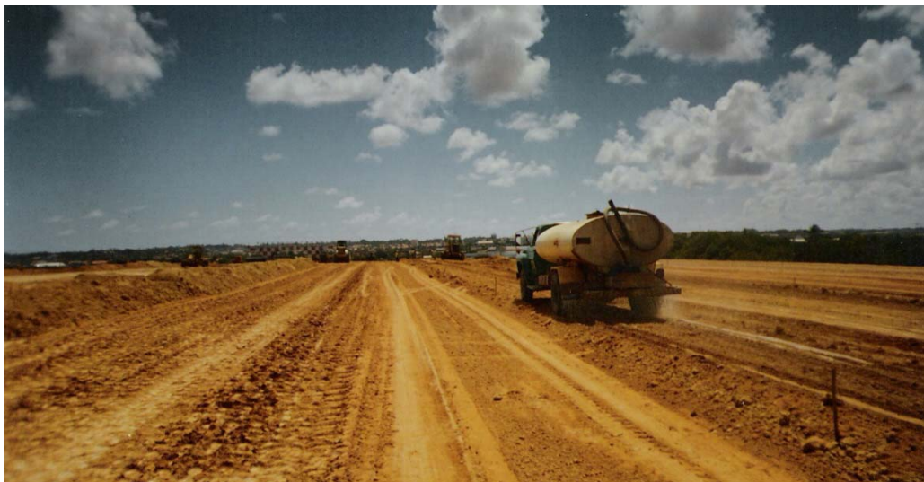
Figura 6: Ajuste da umidade do aterro através caminhões com tanque.
